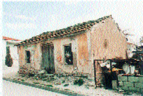
Μονόροφος κατασκευή για επαγγελματική χρήση.
