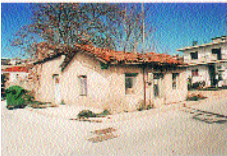
Μονόροφος κατασκευή για επαγγελματική χρήση.
